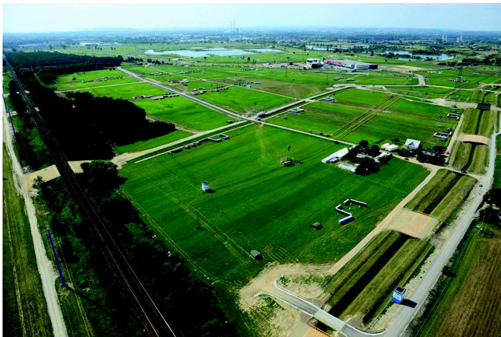
Zdjęcie 2 WSAG Brzegi – widok od strony południowo-wschodniej
