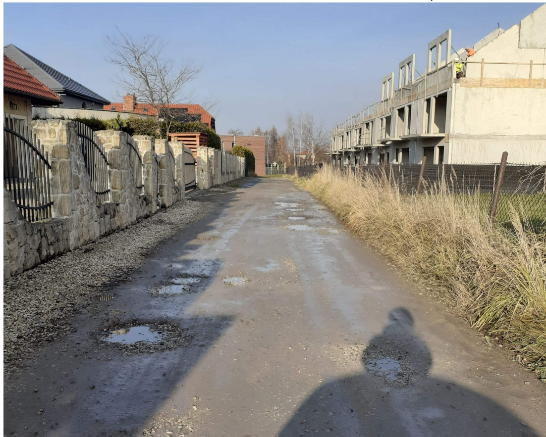
Wykonanie nawierzchni asfaltowej.
