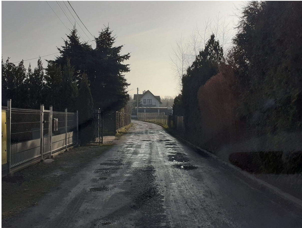
Wykonanie nawierzchni asfaltowej.
