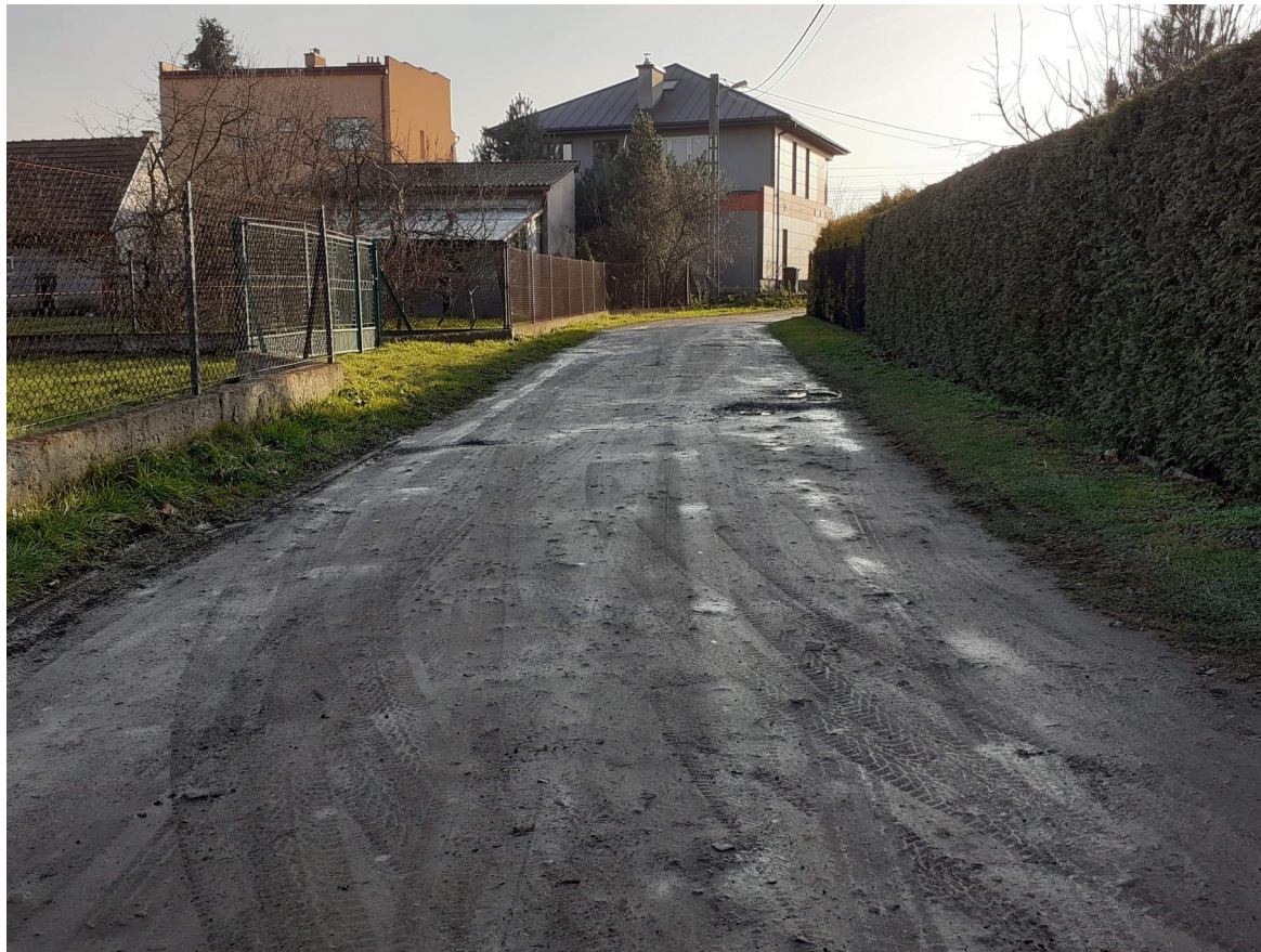
Wykonanie nawierzchni asfaltowej.
