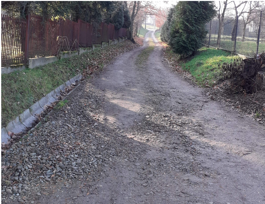
Wykonanie nawierzchni asfaltowej.
