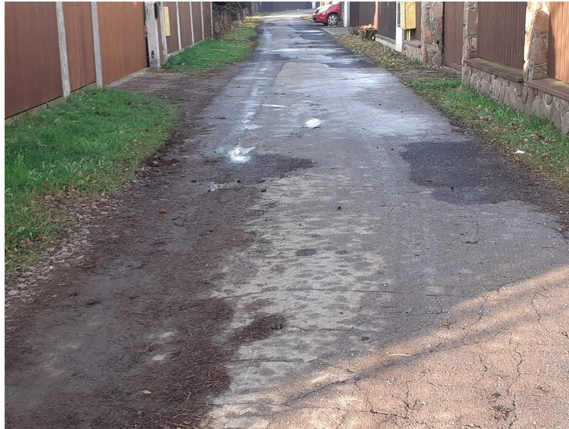
Wykonanie nawierzchni asfaltowej.
