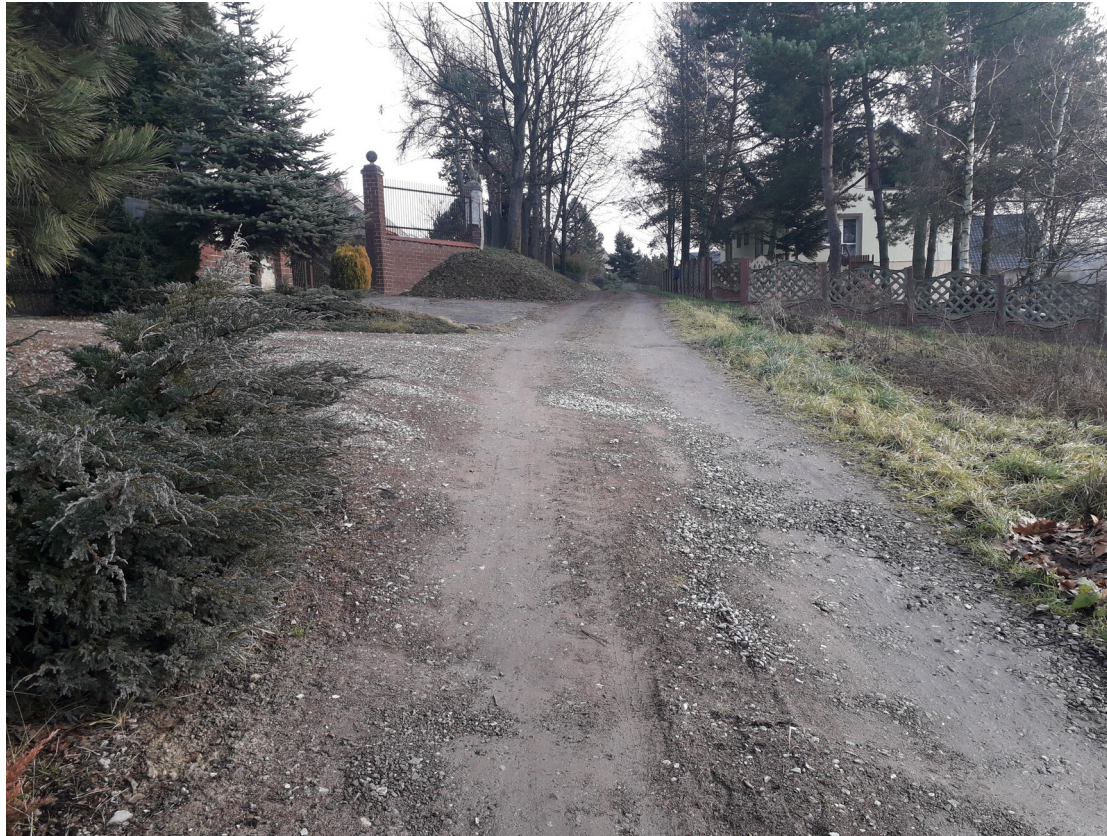
Wykonanie nawierzchni asfaltowej.
