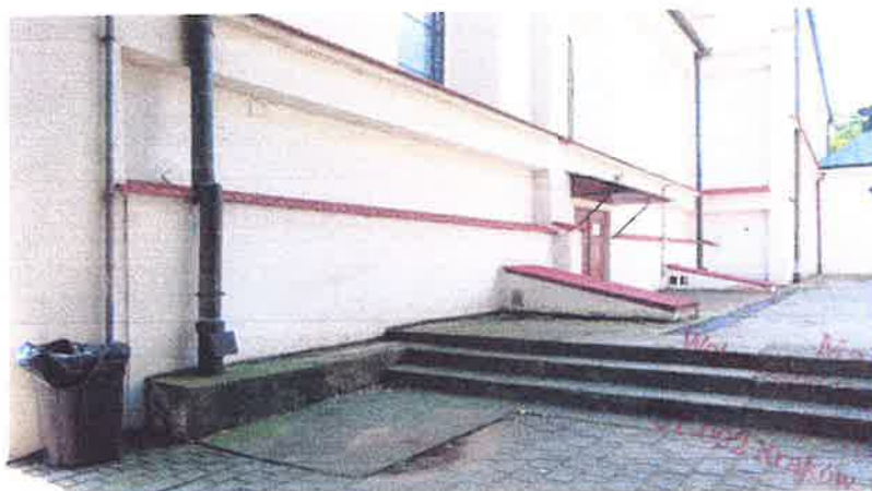
Ściana północna i przyległy plac z trzema stopniami
