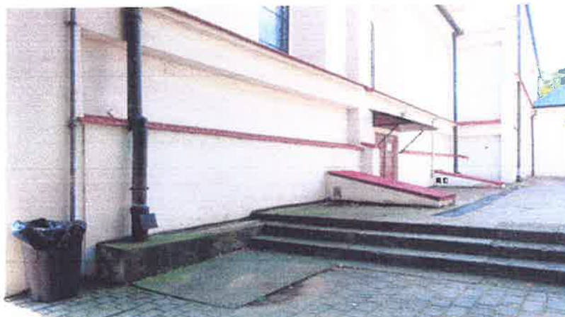
Ściana północna i przyległy plac z trzema stopniami
