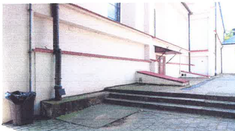
Ściana północna i przyległy plac betonowy z trzema stopniami
